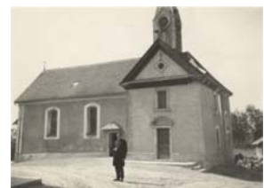
Sakristei von 1912. Wände verputzt, noch ohne neubarocke Westfassade
